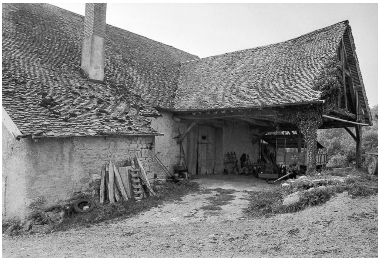
Ferme : vue de la partie agricole.
