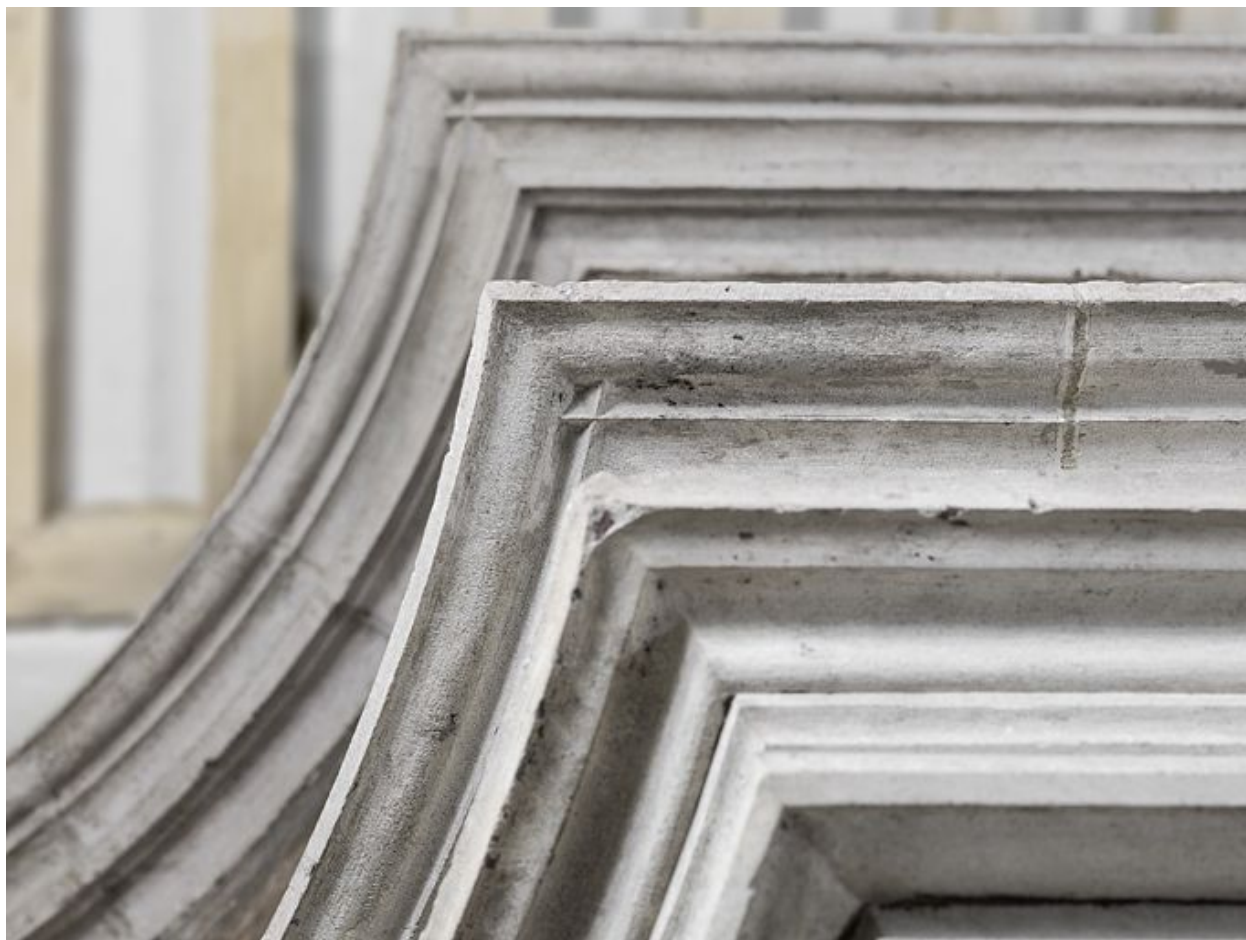
Les moulures du linteau de la cheminée.
