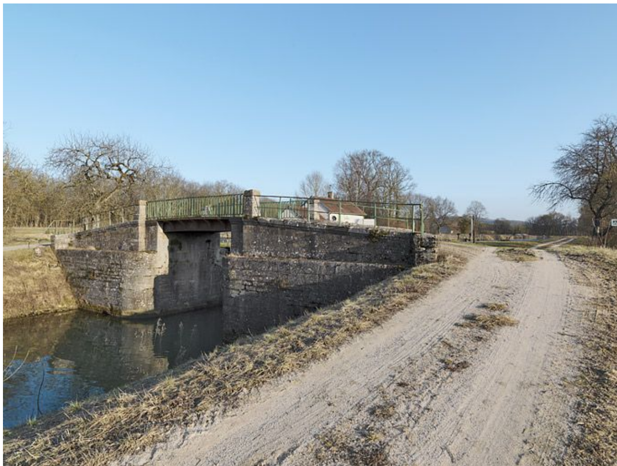
Le pont sur écluse vu d'aval.
