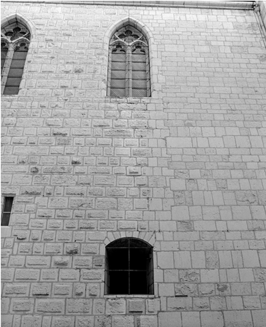
Détail du flanc sud : couture à hauteur de la huitième travée.
