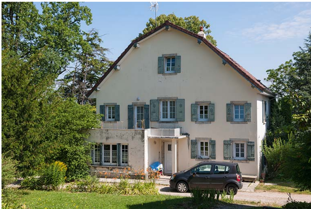
Pavillon du proviseur : façade postérieure.
