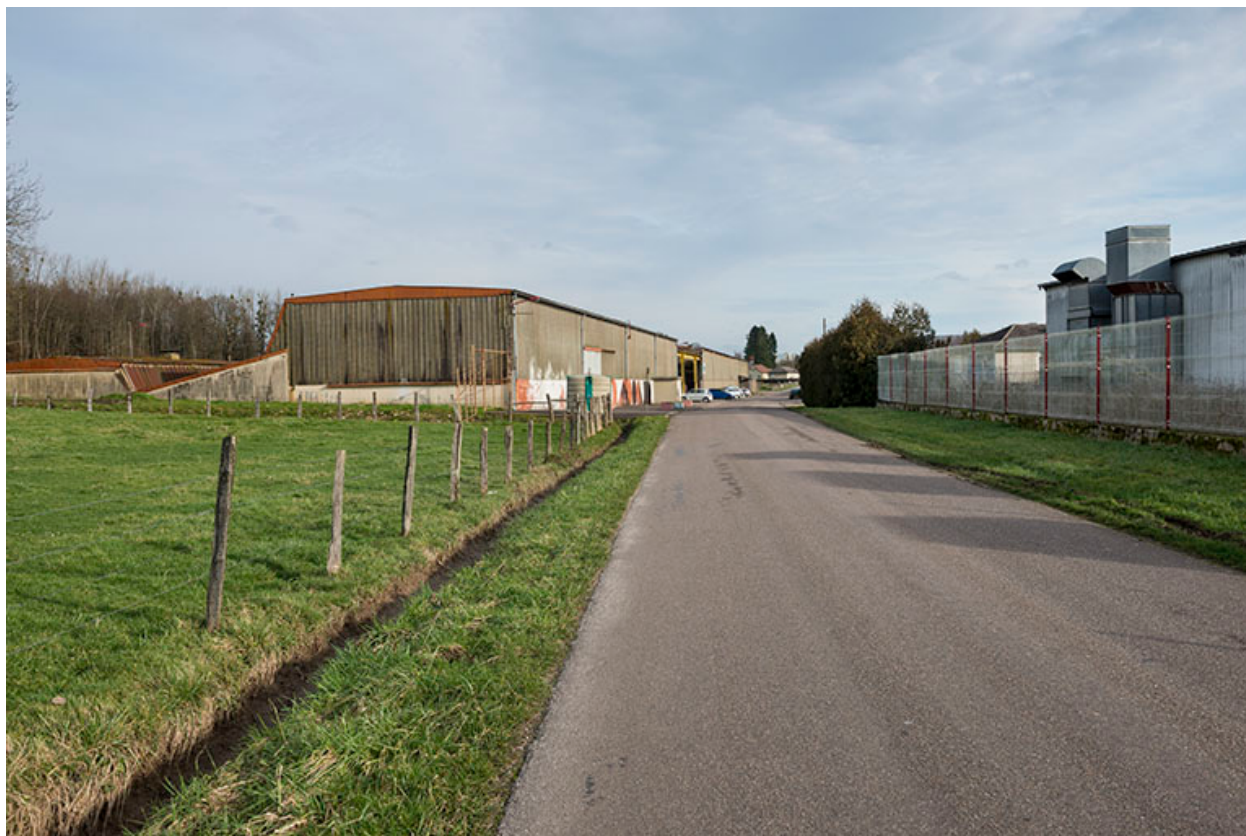
Vue du site depuis le sud-ouest.
