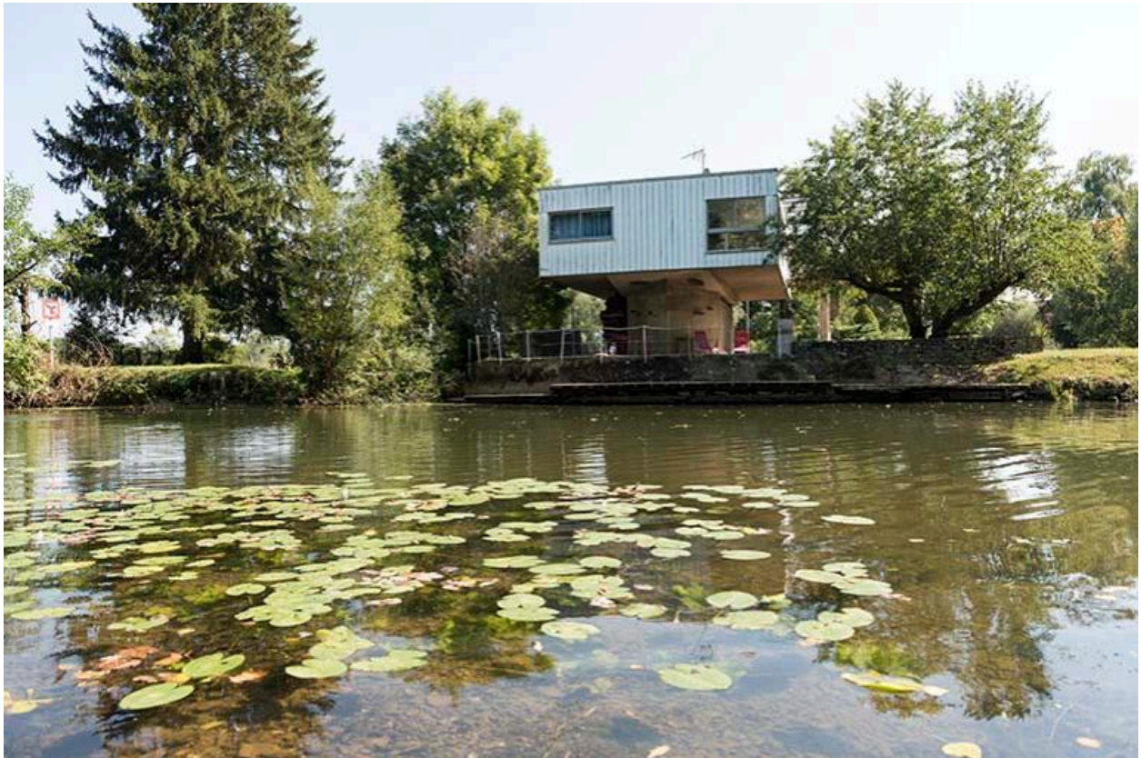
Vue de la façade nord, depuis la rivière
