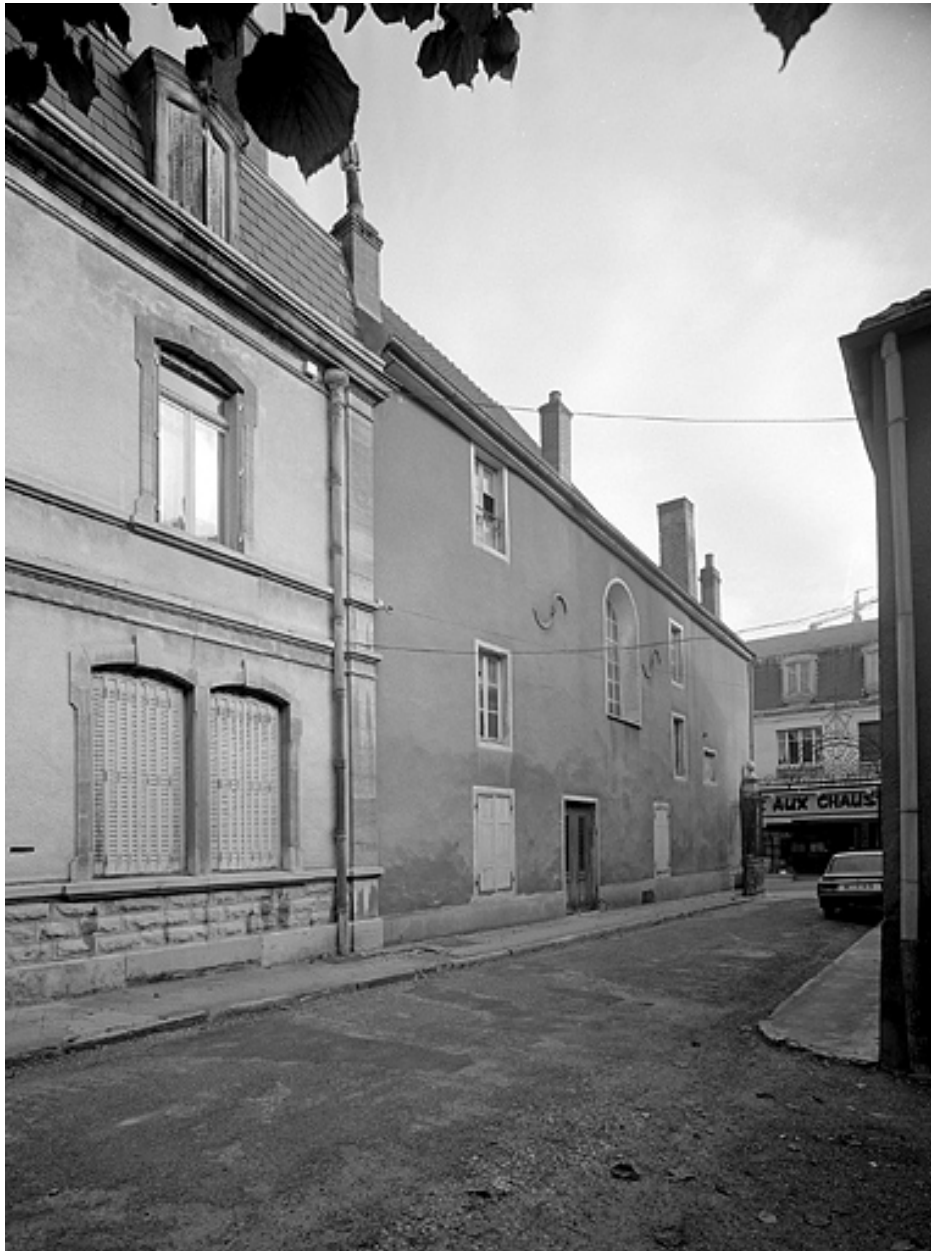
Façade latérale gauche avec une baie d'origine en plein cintre.
