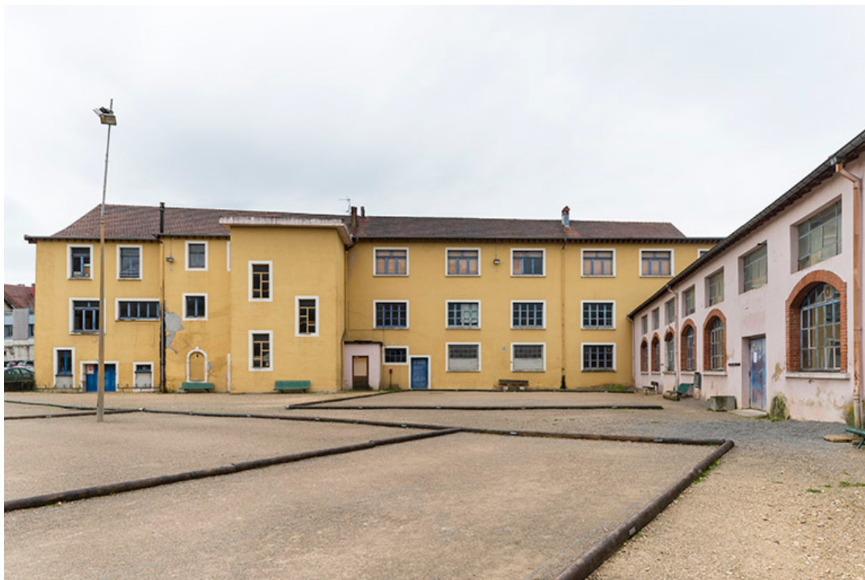
Façade postérieure de l'atelier principal.
