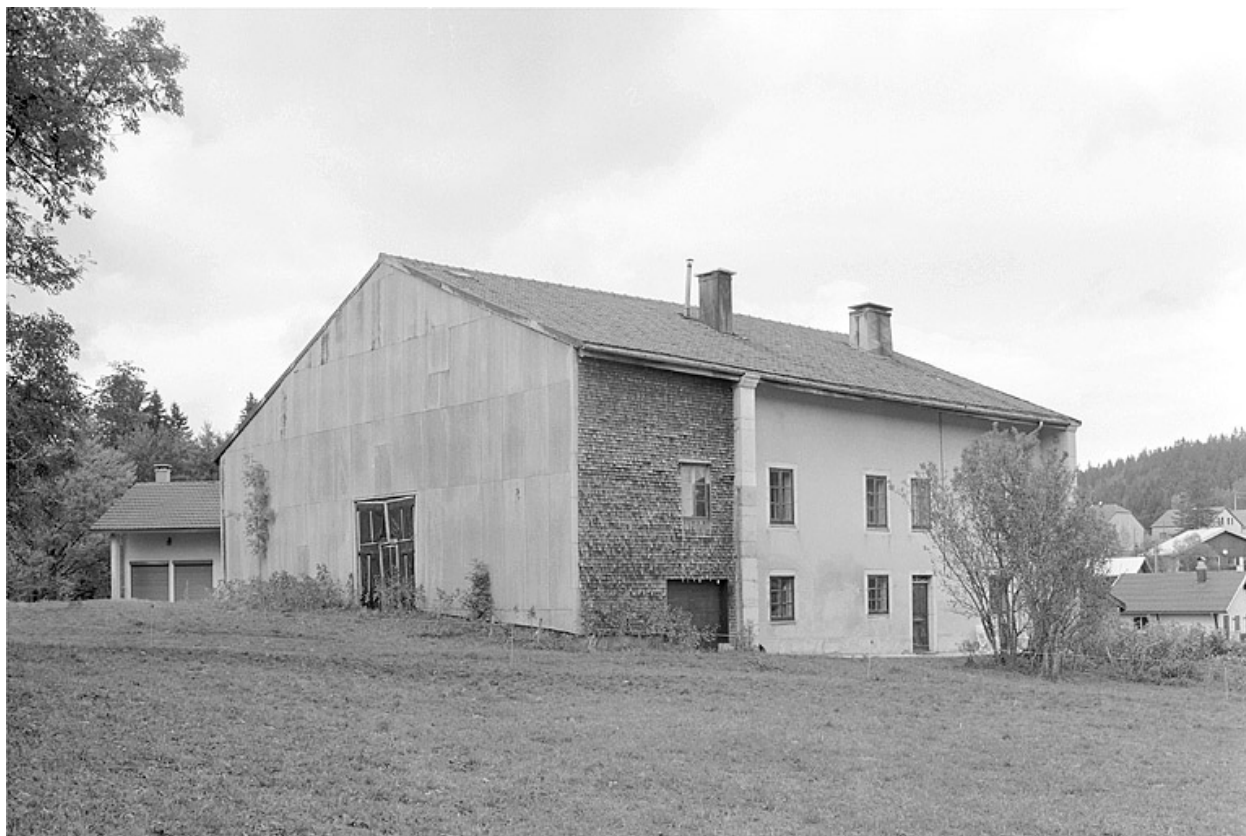
Façade antérieure et face sud-ouest.
