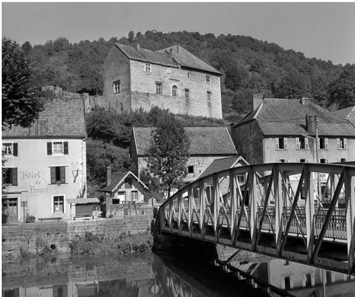
Maison forte dite Le Manoir, située à Lods
