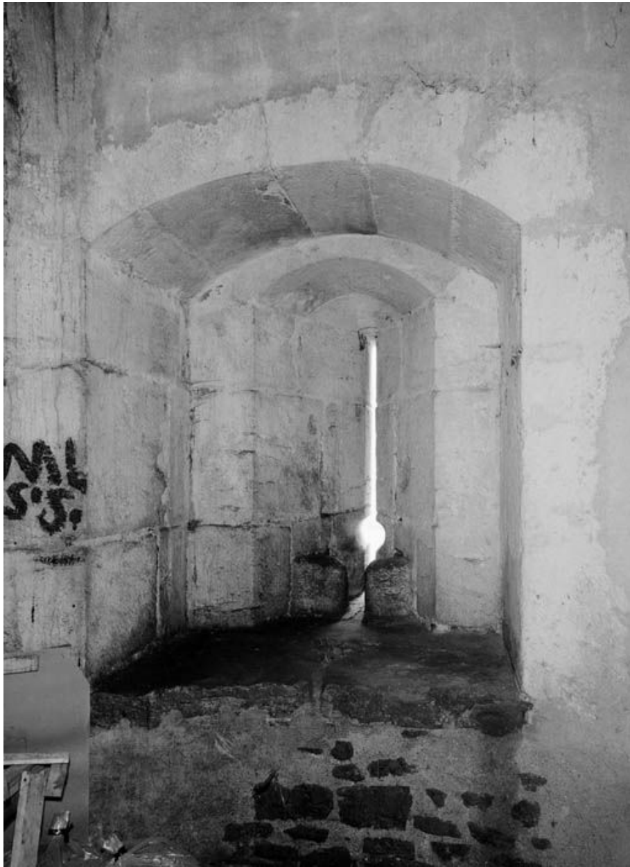
Tour Blondeau, casemate inférieure, détail : archère-canonnière (vue intérieure).
