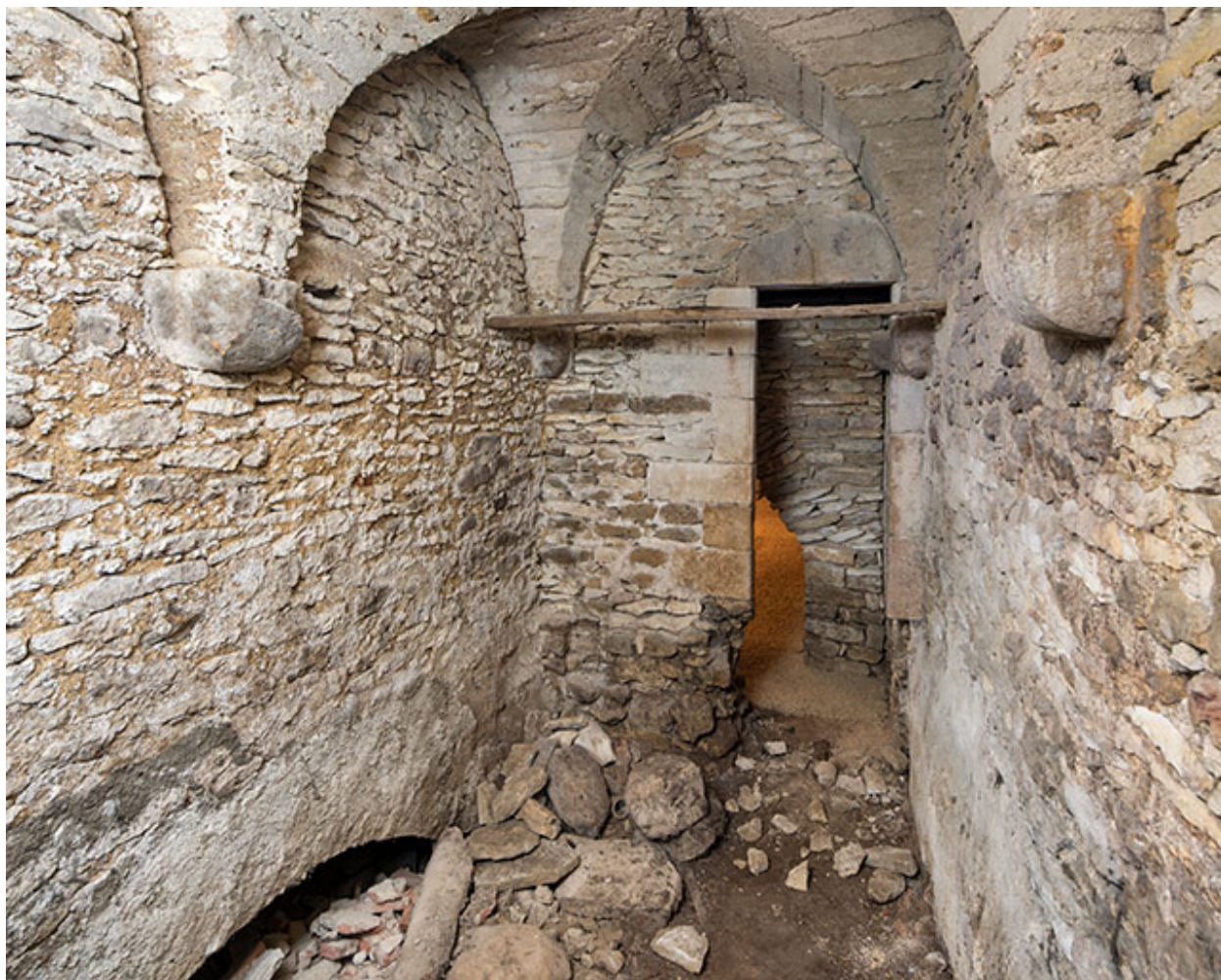
Le premier niveau du colombier, en direction des autres caves.
