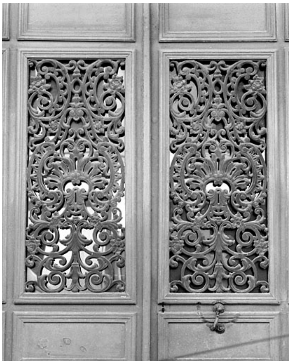
Entrée principale : grille des vantaux.
