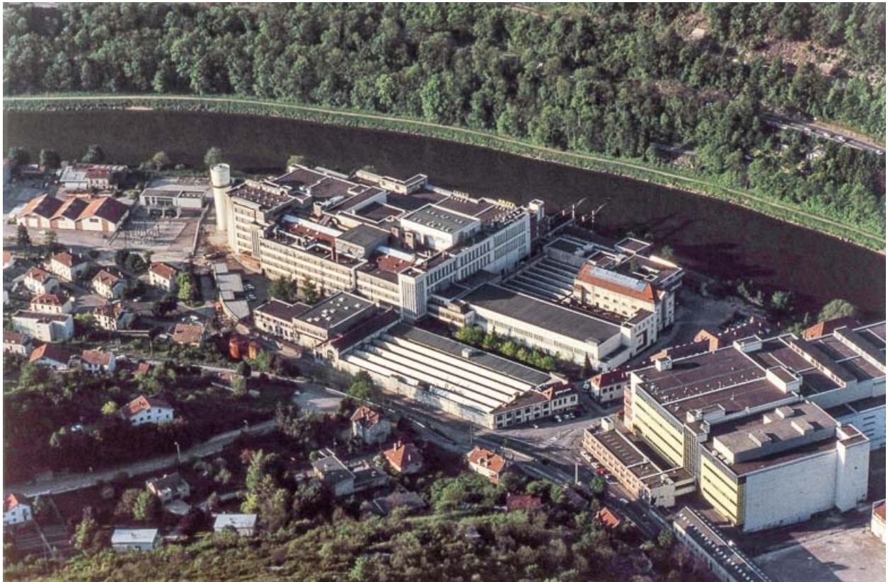
Vue aérienne de l'usine A depuis le nord.
