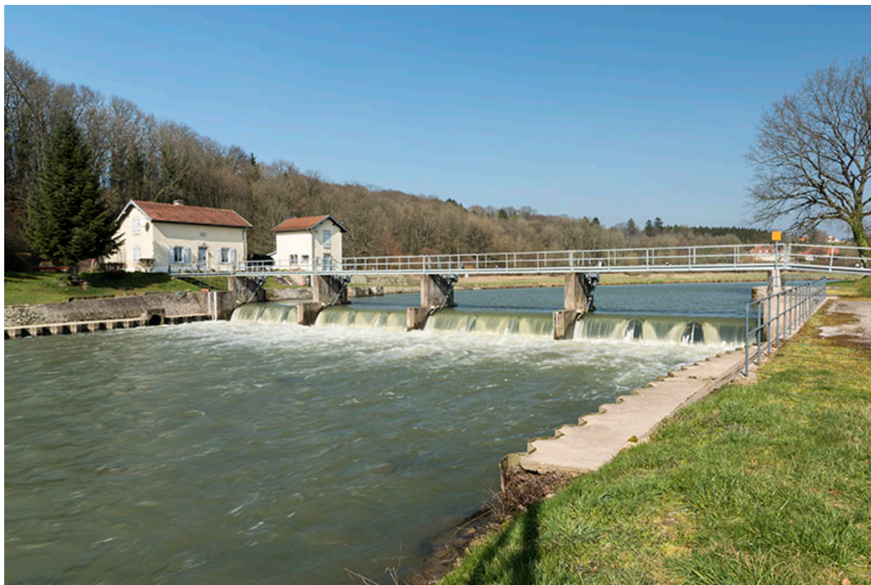
Le site du barrage mobile, vue d'ensemble.
