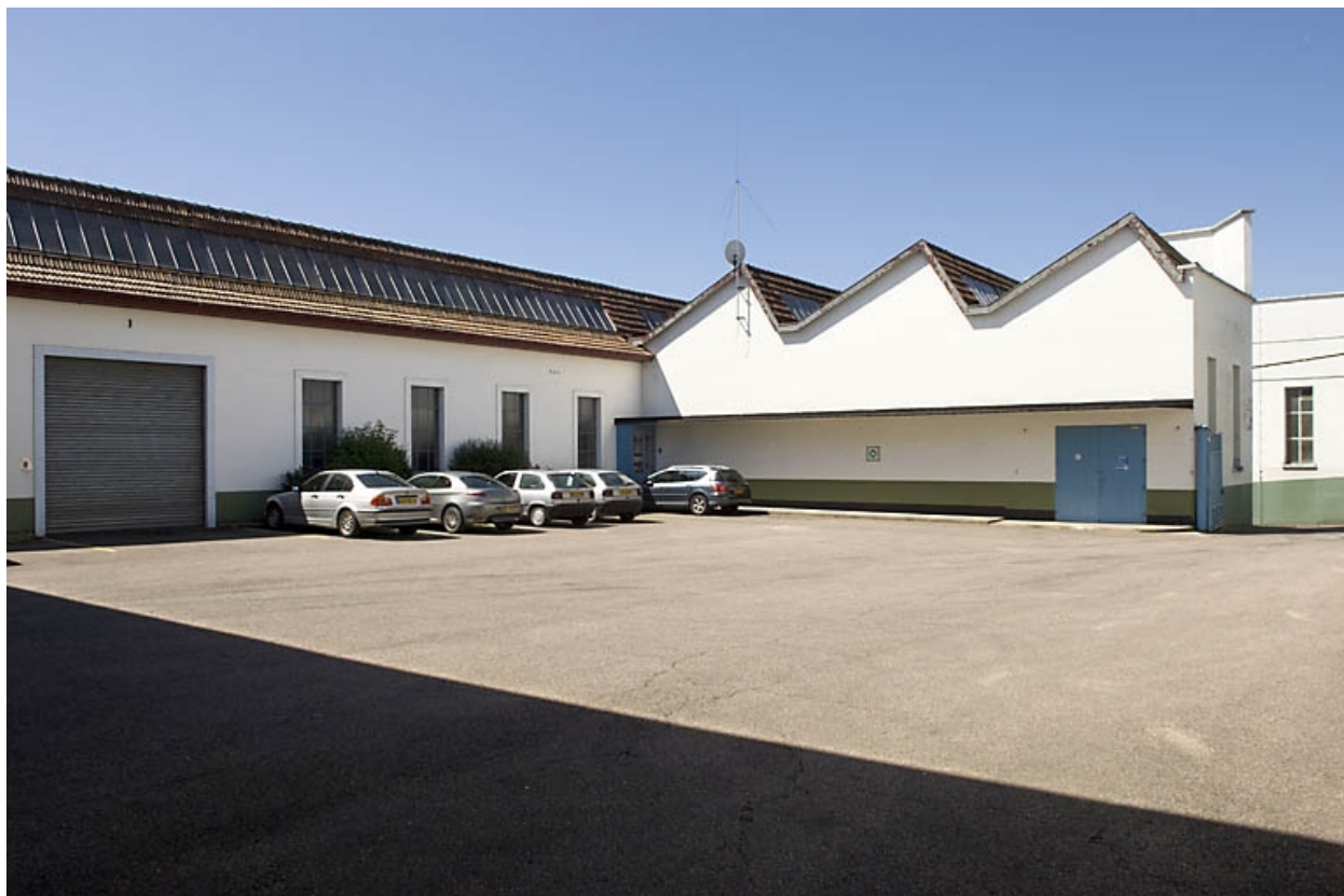
Cour de l'usine. Vue depuis le nord-est.
