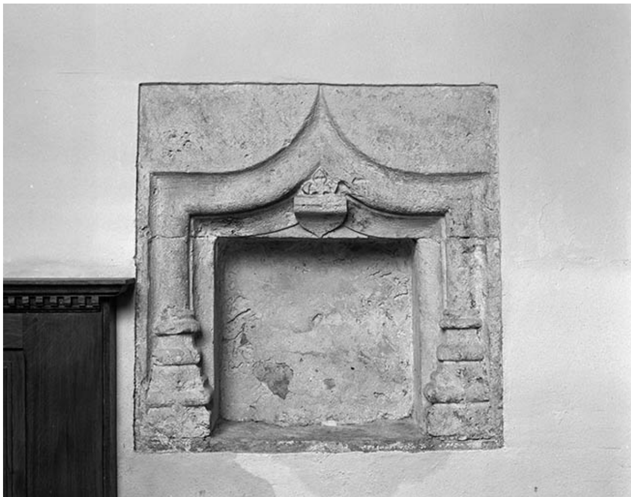
Intérieur : niche du collatéral gauche.
