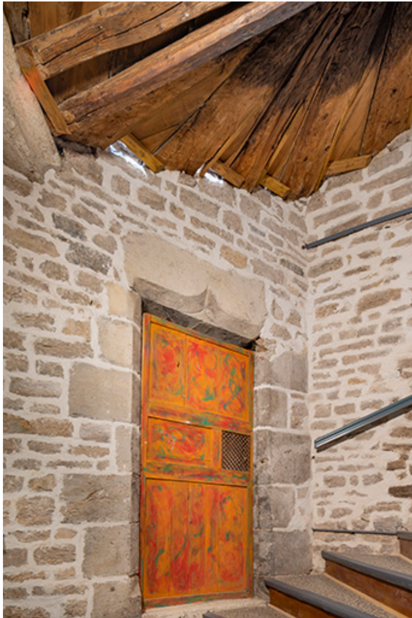
Escalier en vis (entrée n°1 cour des Halles). Porte palière.
