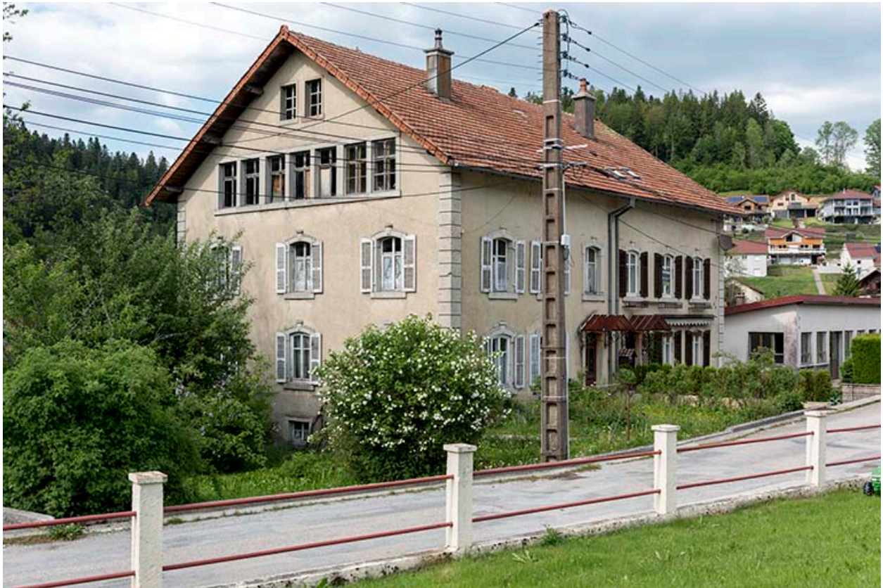
Maison : façades antérieure et latérale gauche.
