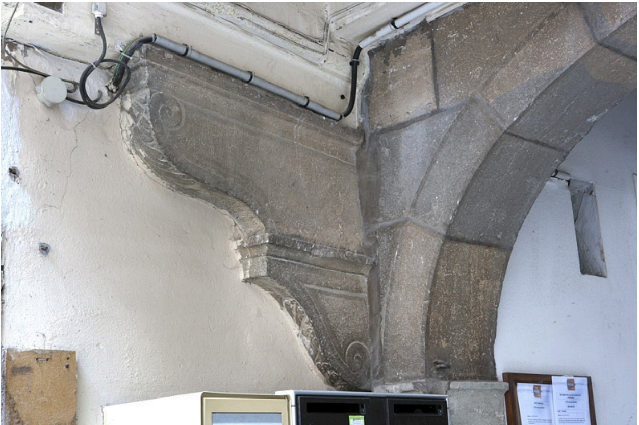
Détail d'une console soutenant la coursière.
