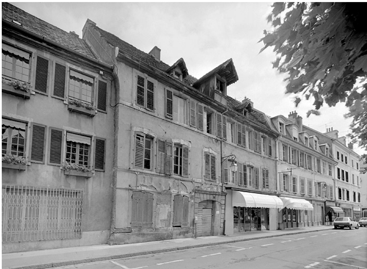
Façade principale sur la place Dorian.
