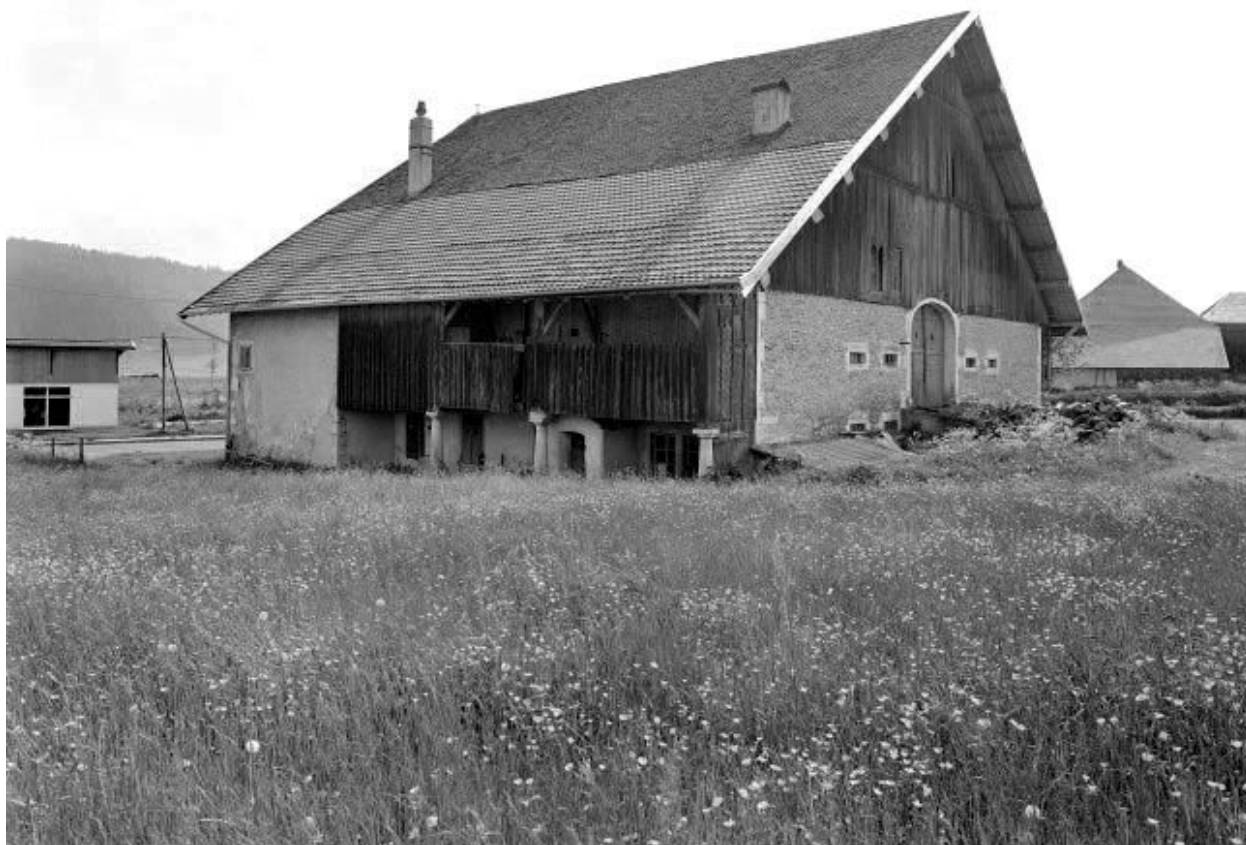
Façades postérieure et latérale droite.
