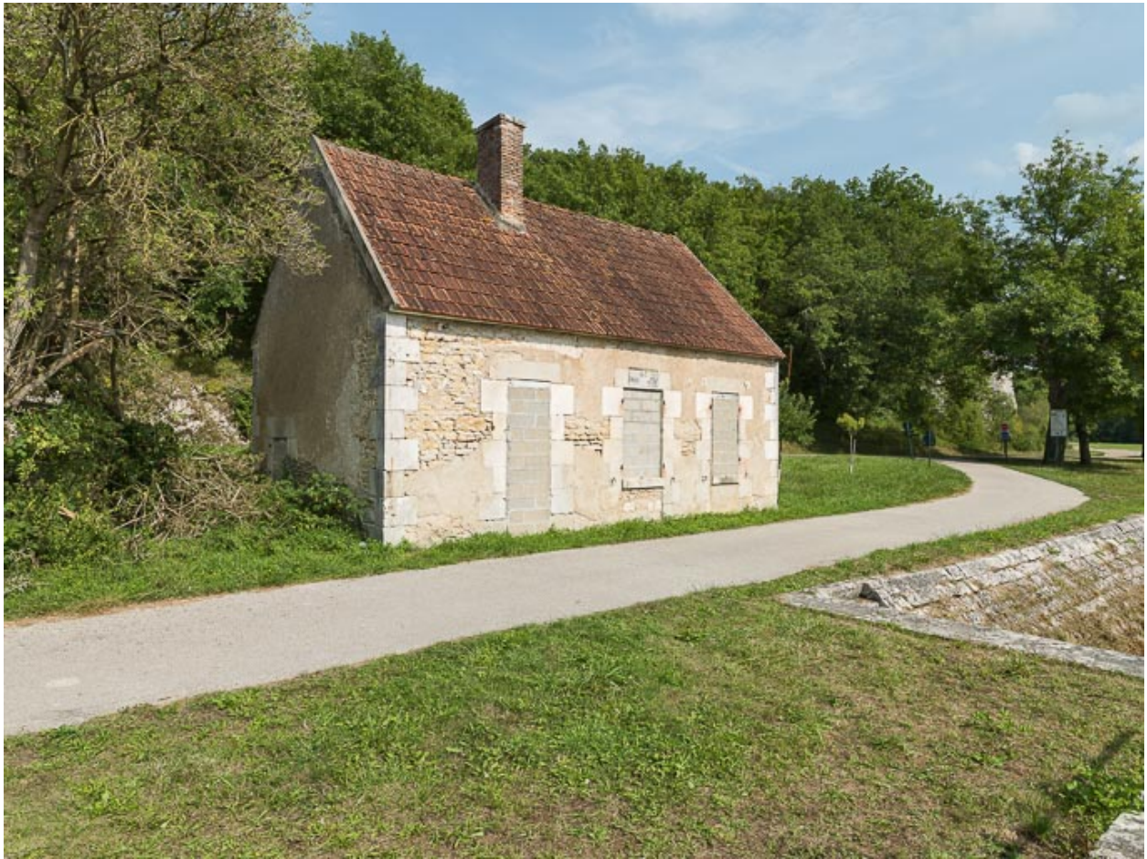
Vue de la maison éclusière.
