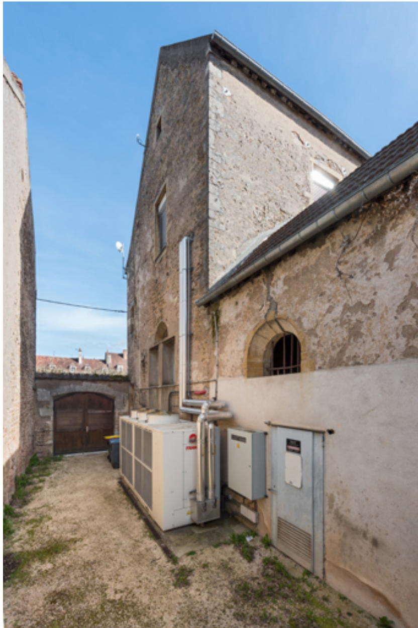
Façade postérieure, vue en enfilade.
