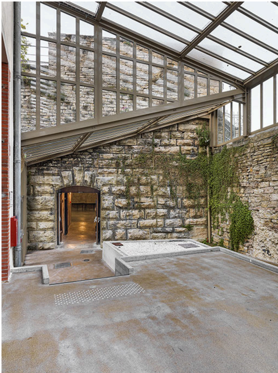
Détail de la maçonnerie et porte d'entrée.
