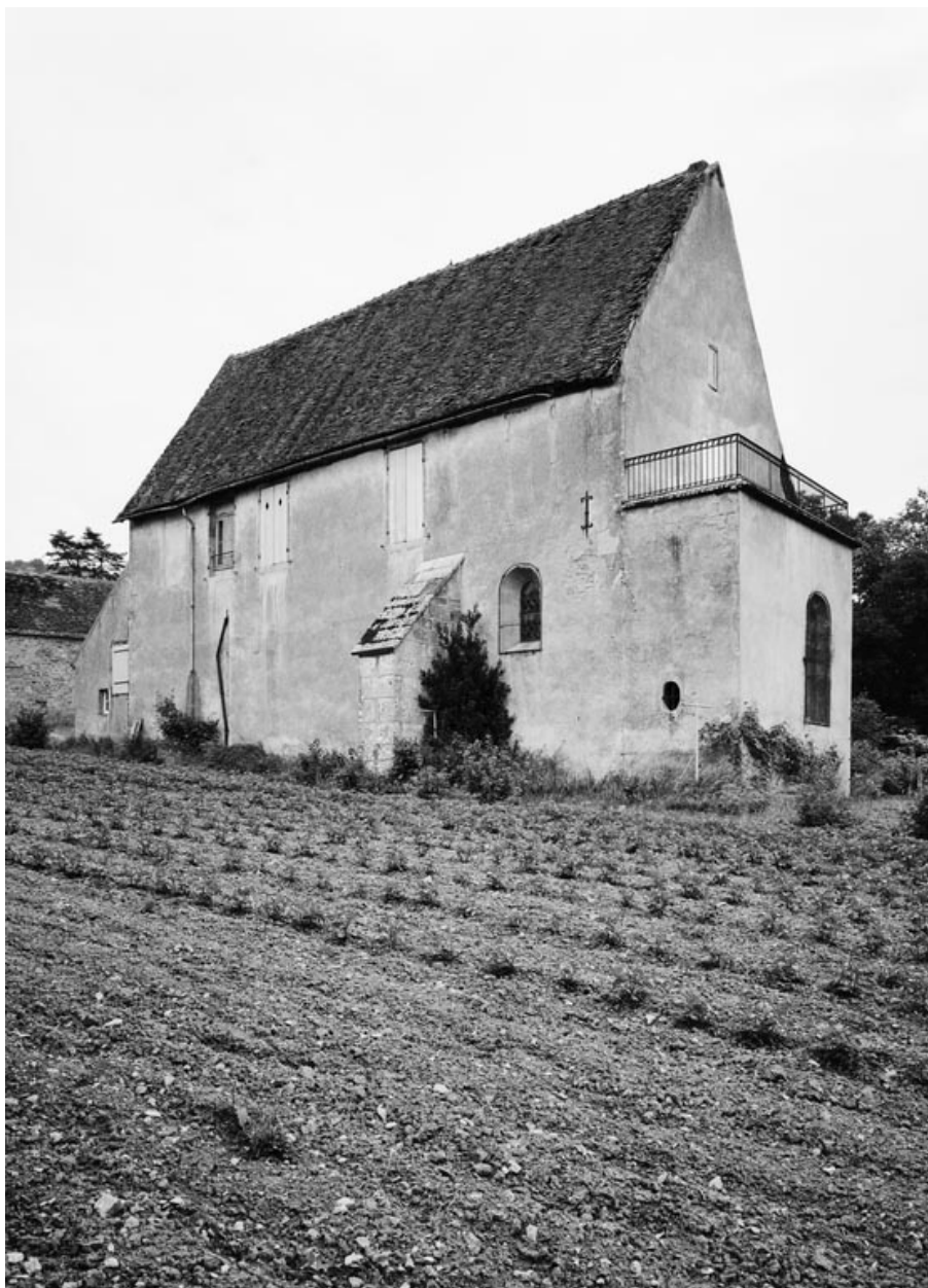
Elévation postérieure du bâtiment de la chapelle.
