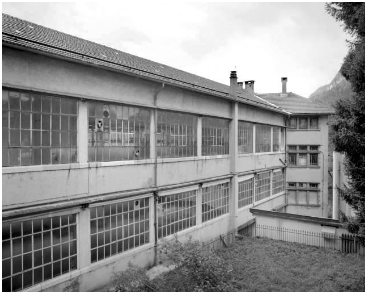
Façade latérale gauche du 2e bâtiment.
