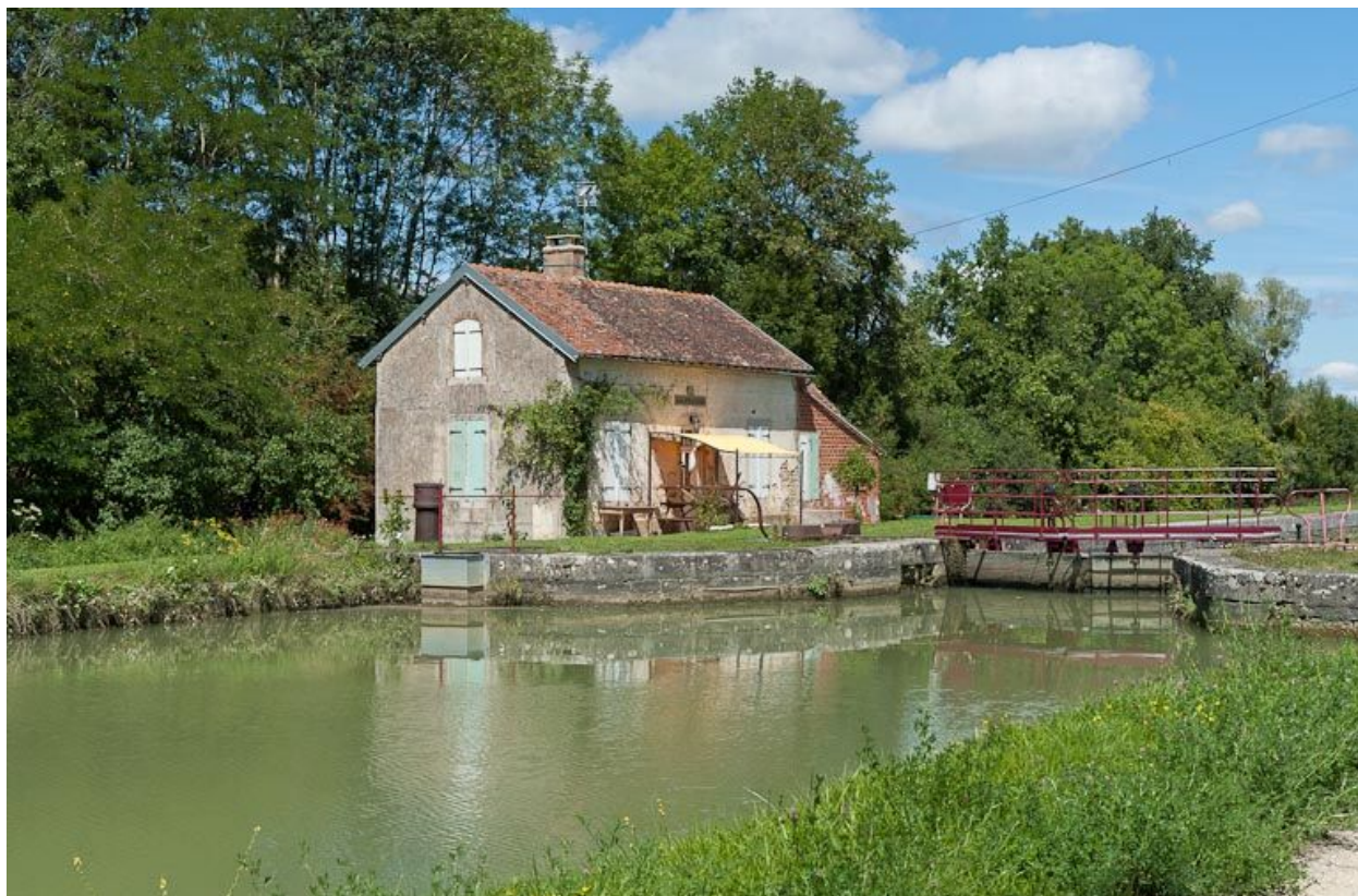
Vue du site d'écluse depuis l'amont.
