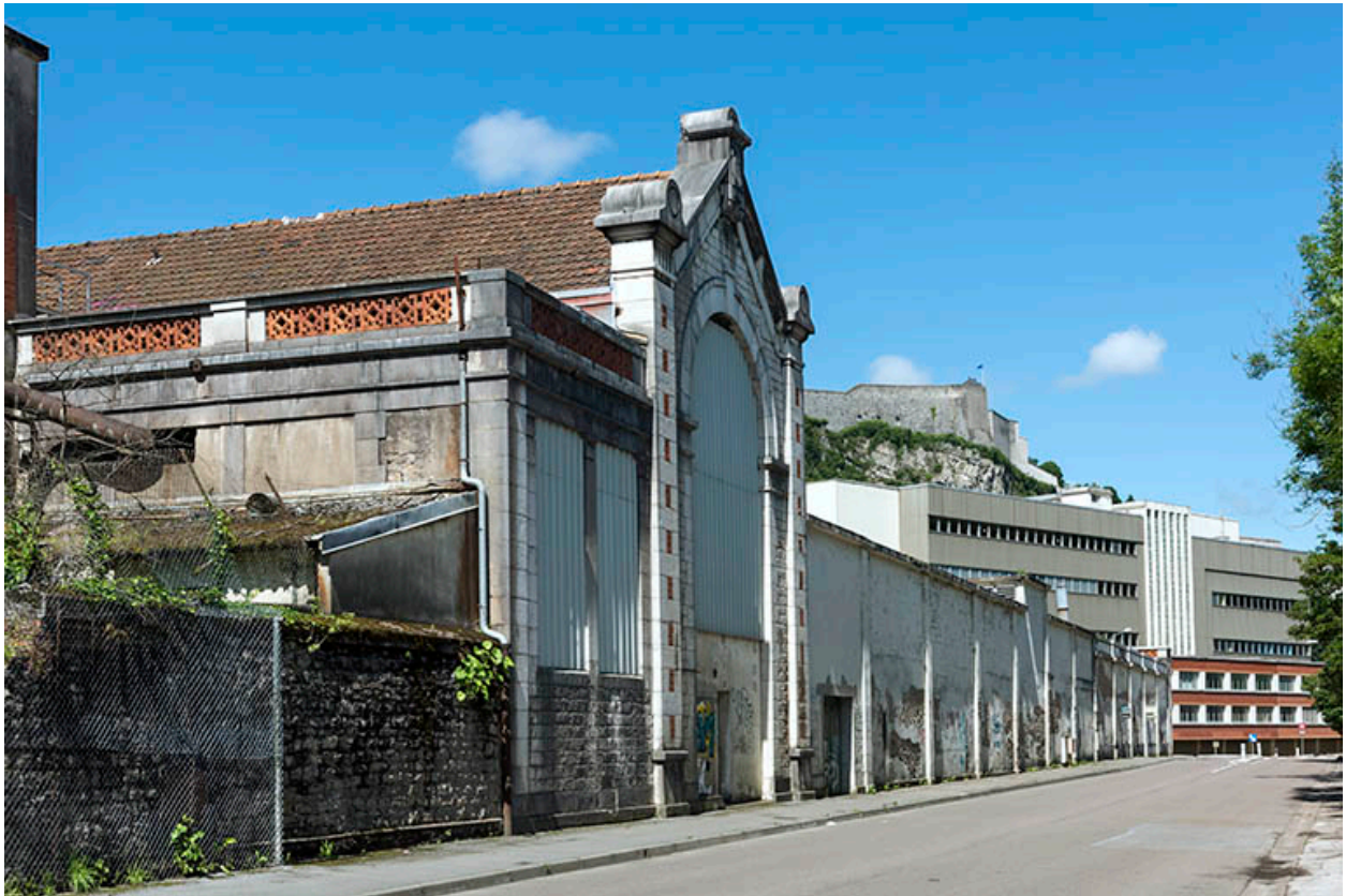
Etat en 2016. Usine A : façade sur rue de la chaufferie, vue en enfilade.
