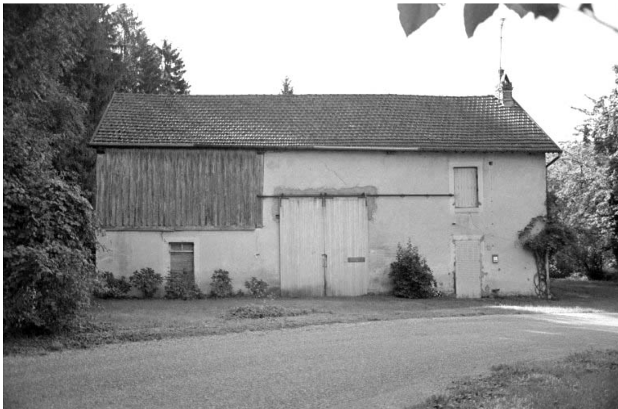
Façade antérieure du logement de contremaître (D).
