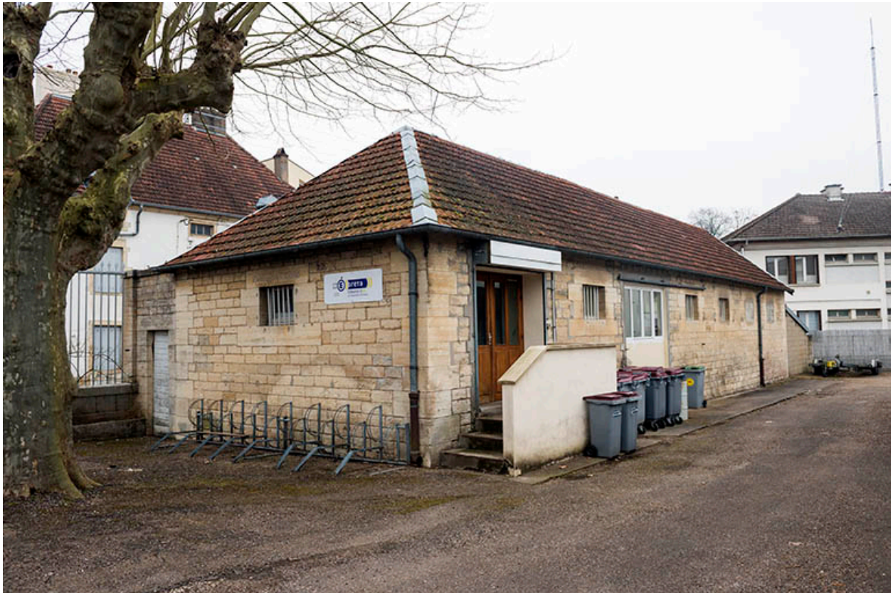
Angle sud-est de l'ancien corps de garde.
