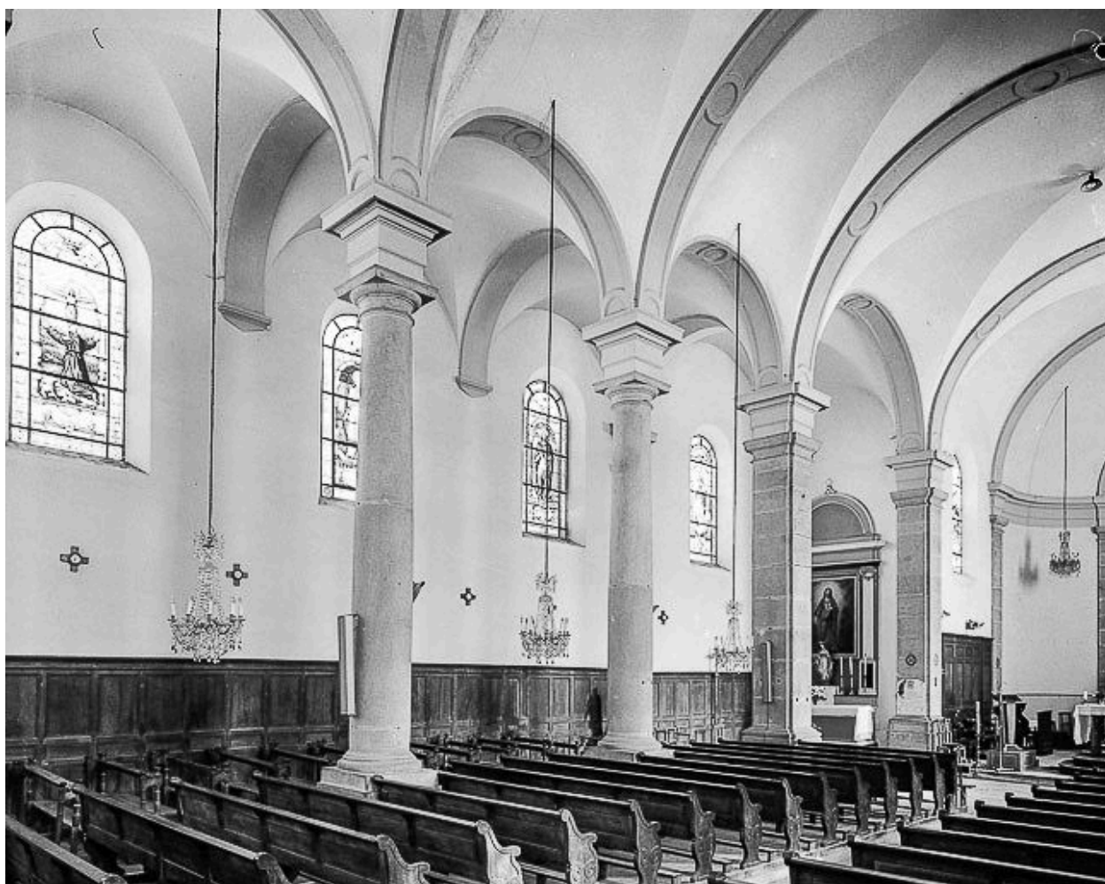
Intérieur : élévation gauche de la nef.
