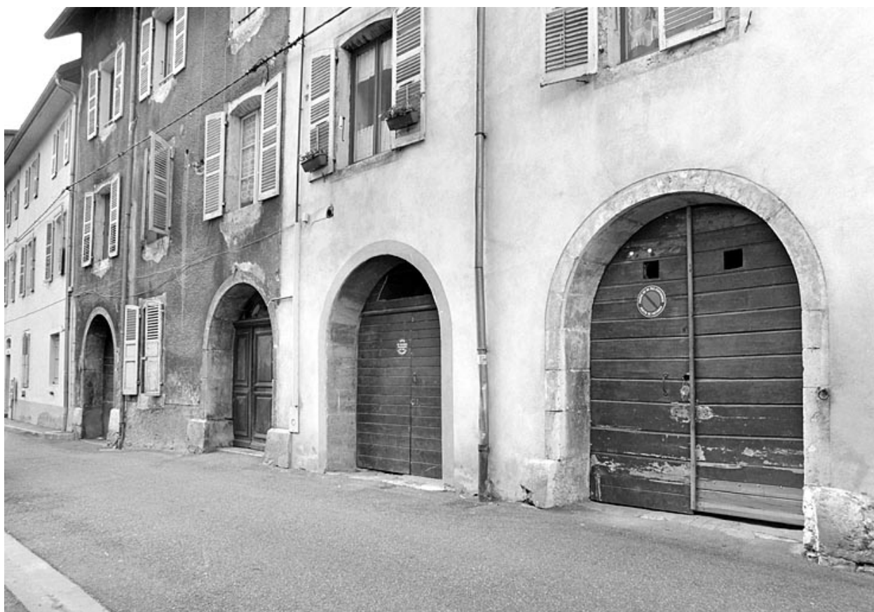
Maison au n° 30 : baies du rez-de-chaussée.
