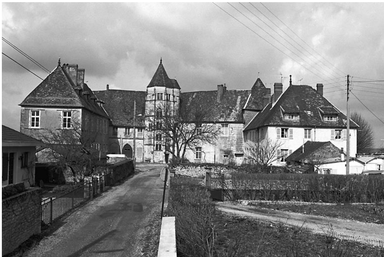
Façade antérieure sur cour
