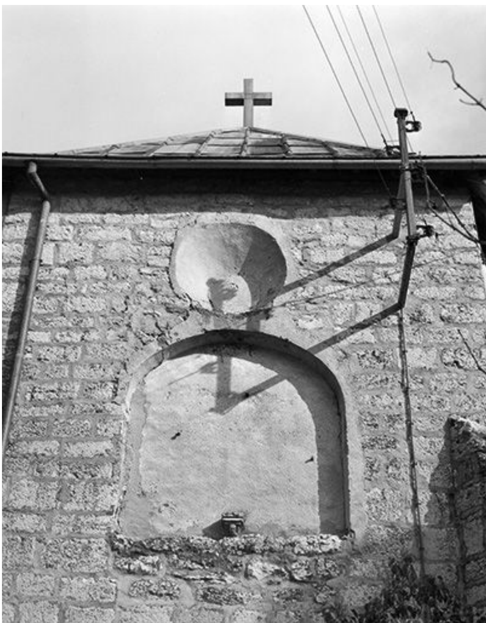
Baies murées du chevet.
