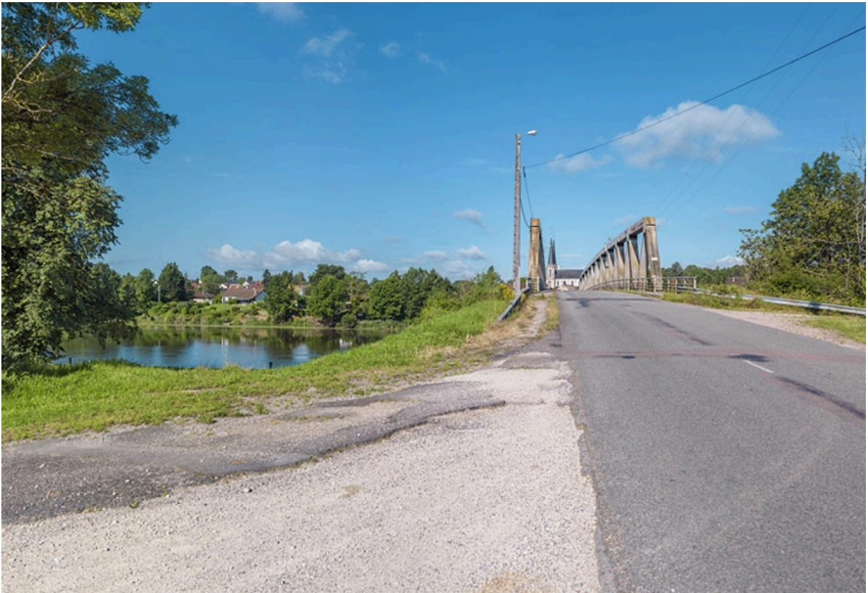
Vue d'ensemble, rive gauche.
