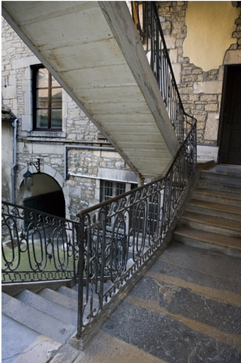
Vue d'ensemble de l'escalier à cage ouverte depuis le premier palier.
