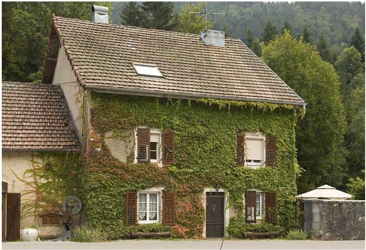
Maison : façade antérieure.
