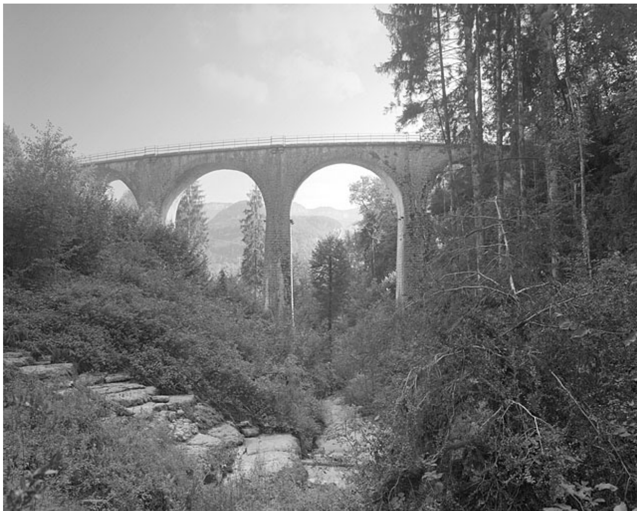
Le viaduc depuis le ruisseau du Nans.
