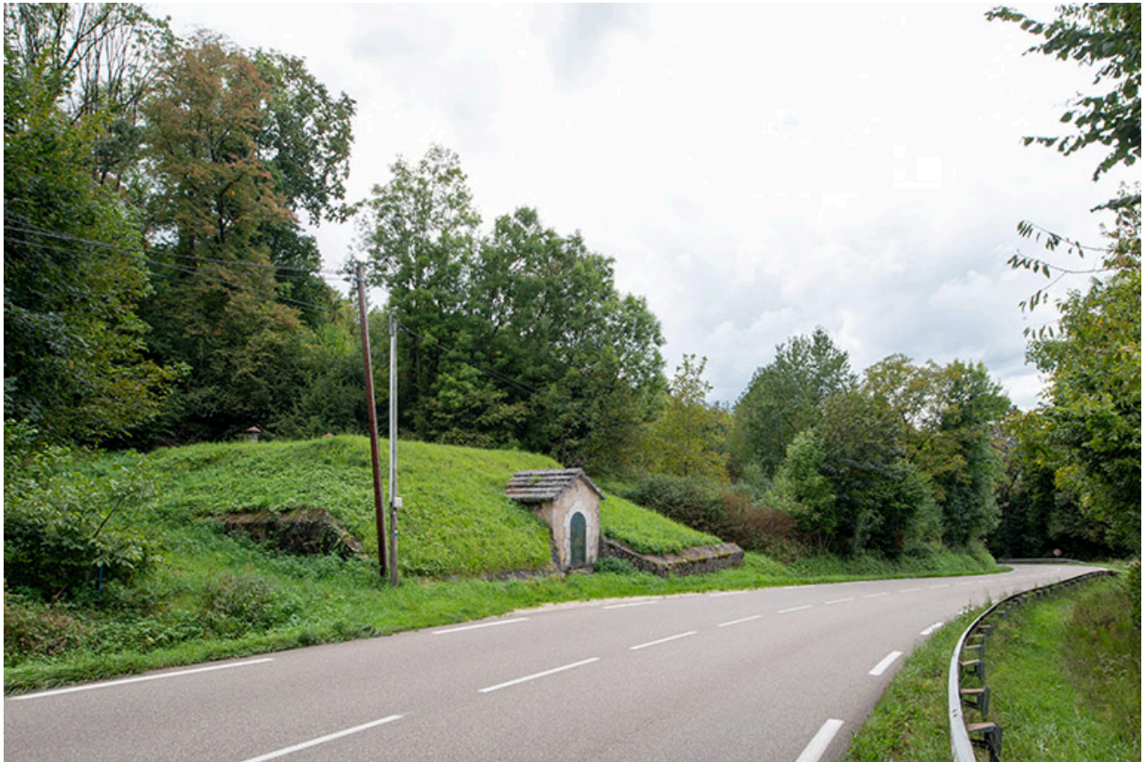
Réservoir de Veley (1910), R.D. 472. Vue depuis l'est.
