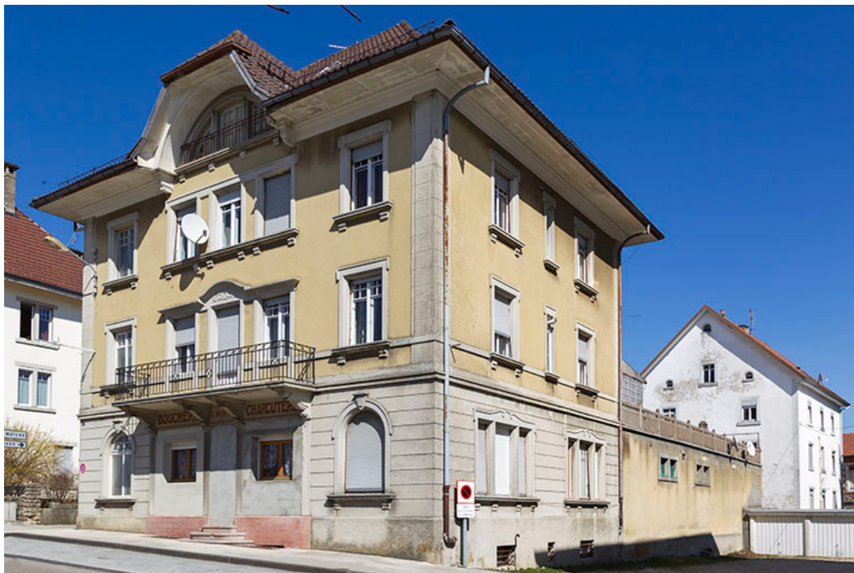
Façades antérieure et latérale droite.
