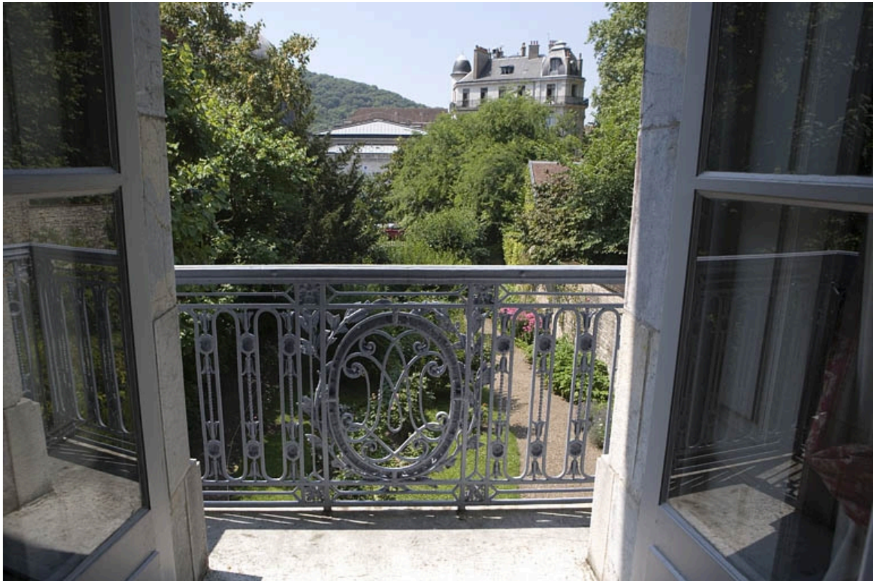
Hôtel en fond de cour : détail de la grille du balcon donnant sur le jardin, depuis l'intérieur.
