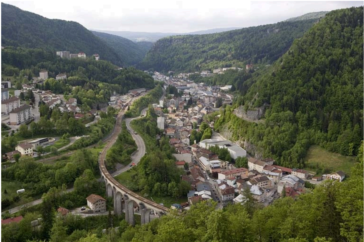
Vue d'ensemble de la voie et de la ville de Morez, depuis le viaduc des Crottes.
