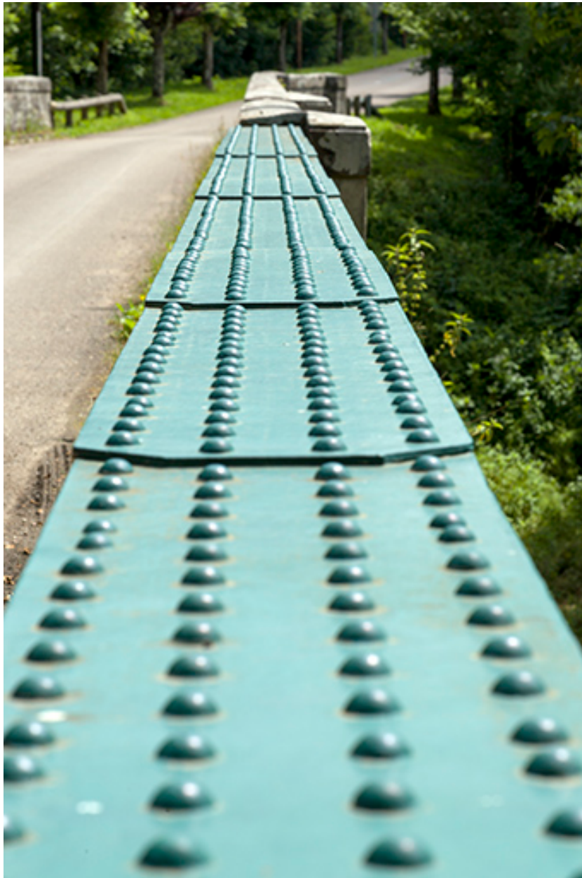
Détail de la rambarde de la passerelle.
