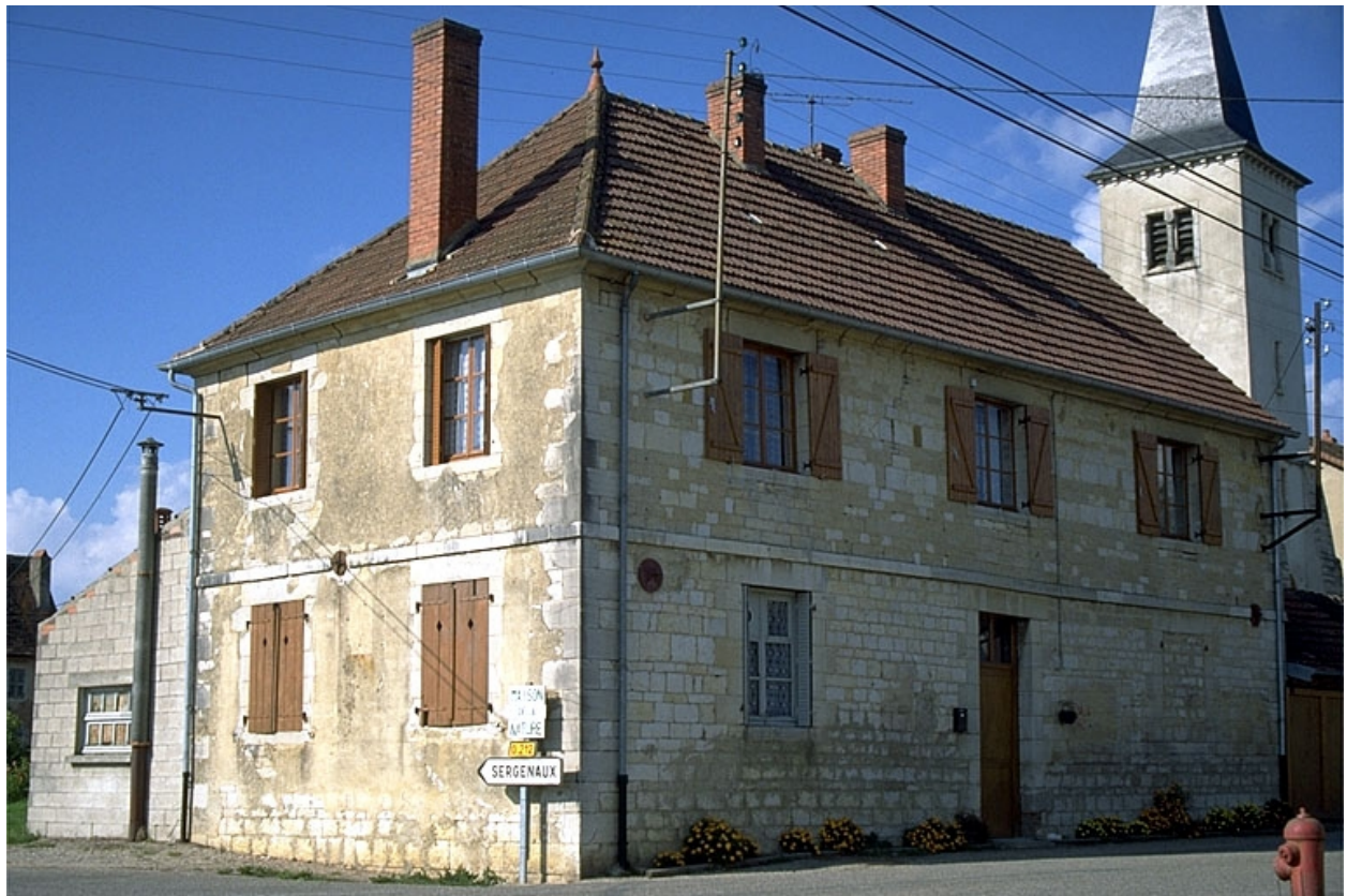
Ancienne école, vue de trois quarts gauche.
