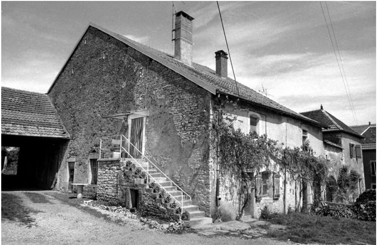
Vue de l'habitation.
