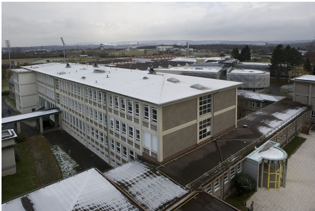
Vue d'ensemble depuis la tour d'internat.
