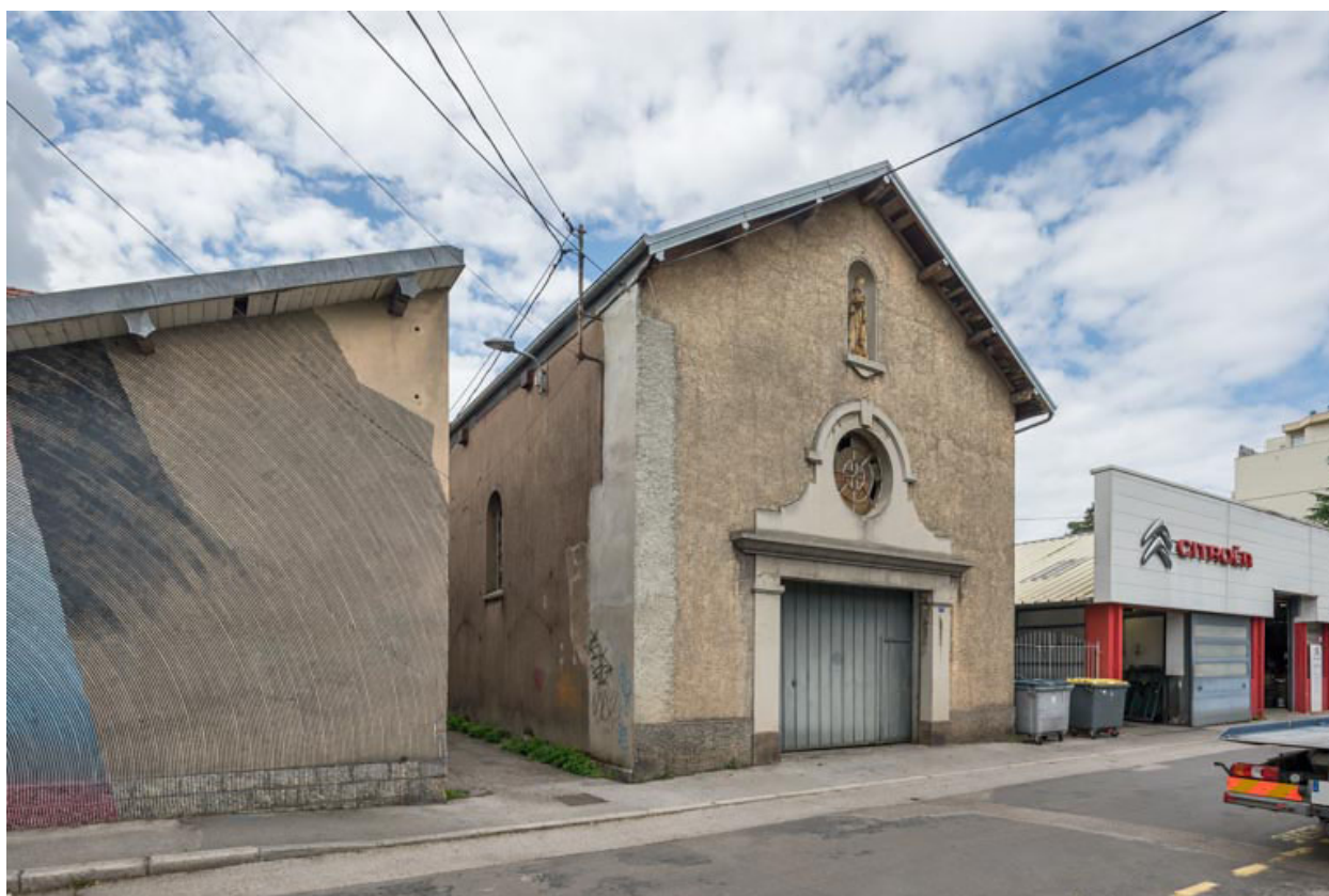
Façade antérieure. Vue d'ensemble.
