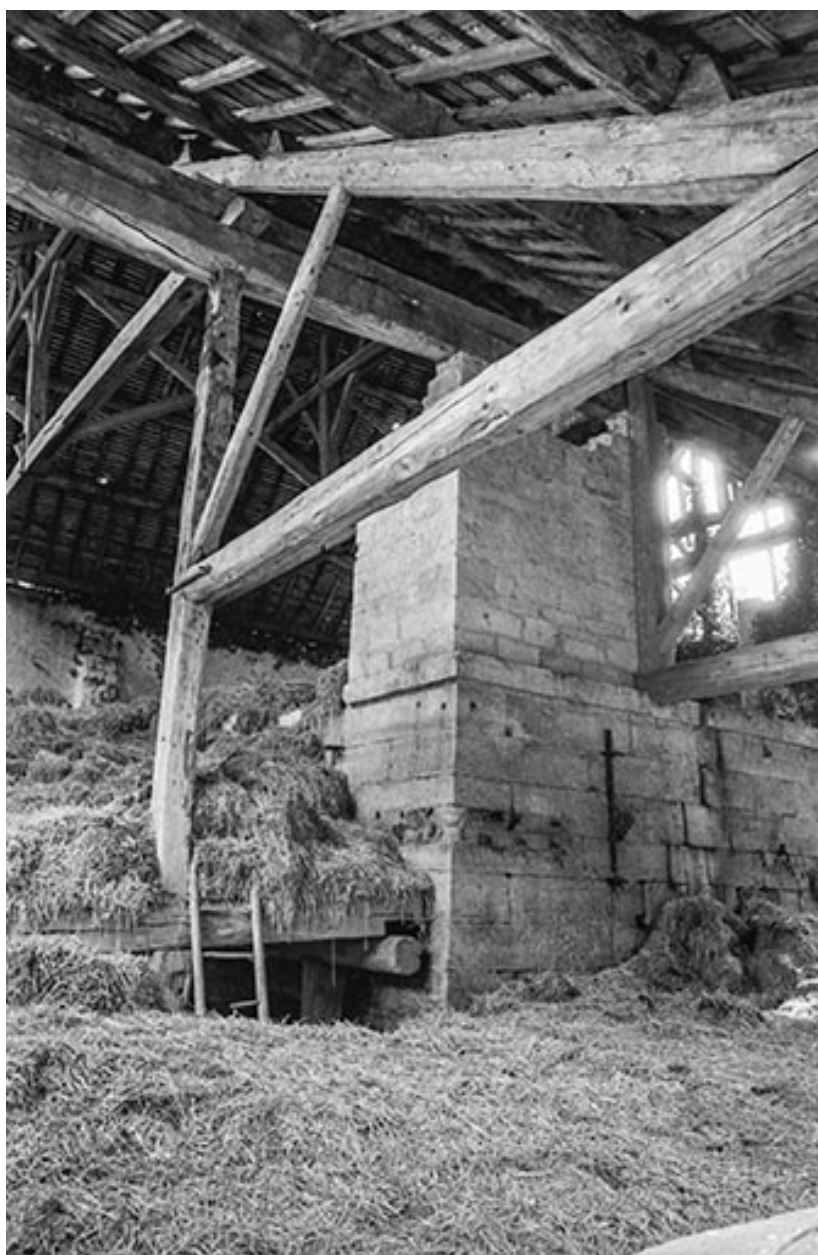
Partie supérieure du haut fourneau en 1980.
